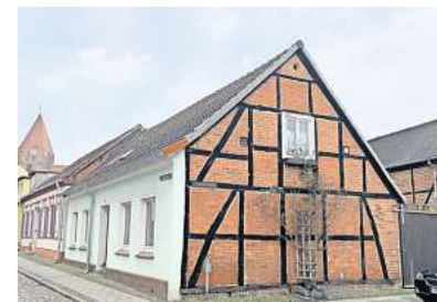
In der Badstüberstraße, Ecke Hafensstraße befand sich einst die Badestube in Grimmen.
