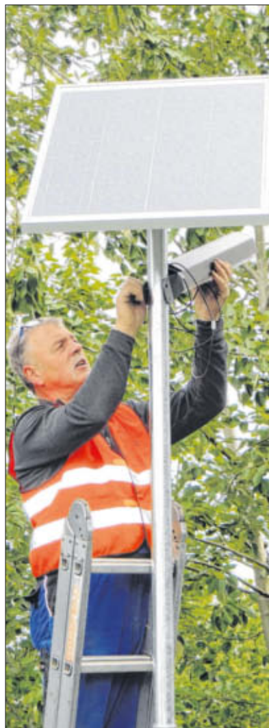
Arno Junge montiert die Lampe unterhalb des Solar-Panels.
