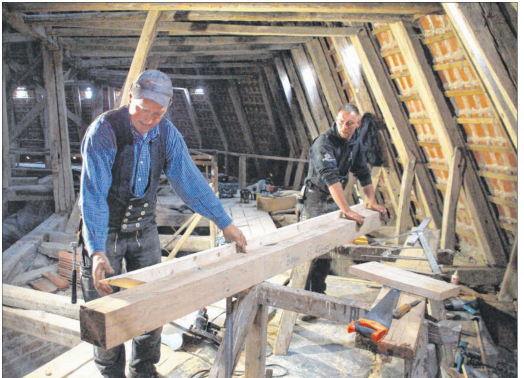
Der Dachstuhl der Grimmener Marienkirche ist im Herbst aufwendig saniert worden. Die Zimmermänner Jörg Holznagel und Sebastian Stöhr haben einen der eindrucksvollsten Arbeitsplätze in Grimmen. Die Sanierungsarbeiten kosten rund 200 000 Euro, die Hälfte steuert der Bund bei.
